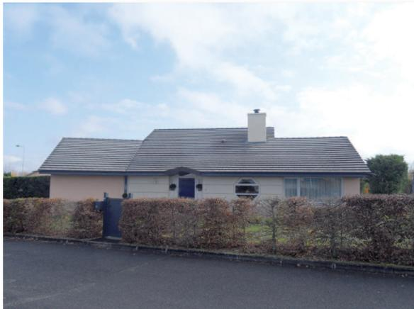
Commande privée, le lotissement est composé de trente-quatre pavillons, construits à partir d'un bloc commun standard. C'est la position du bloc garage qui donne plus ou moins de chambres, créant la variété des types. La structure est mixte, maçonnerie extérieure et ossature bois intérieure.
